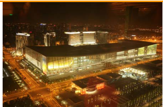
图表4 北京奥运工程之国家会议中心
