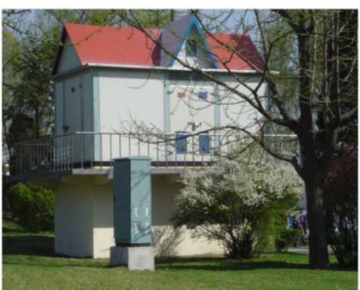
智能箱式变电站 应用于城市亮化工程
