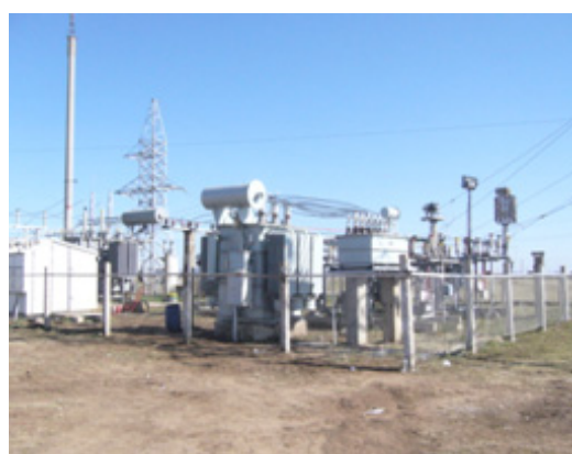
磁控并联电抗器型动态无功补偿装置 应用于蒙古国家电网、神华集团、徐州东南钢铁集团、山西朔州中煤金海洋集团等
