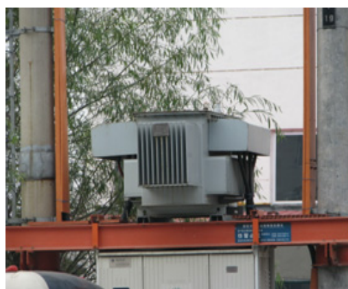
SH15-M 系列非晶合金油浸式变压器 应用于城、农网改造工程
