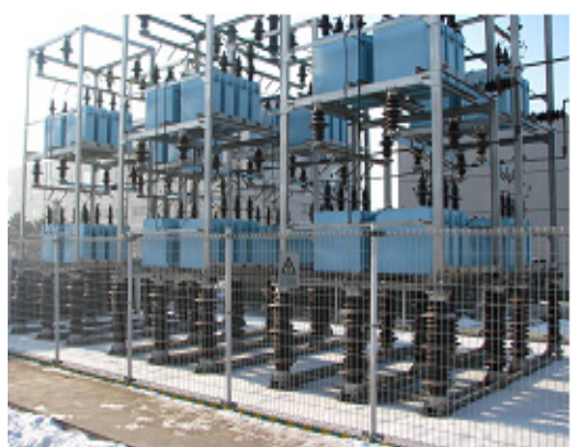
高压并联电容器成套装置 用于 500kV 内蒙树林召变电站
