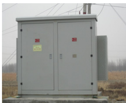
风力发电用组合式变电站 应用于大庆巴彦查干风电场
