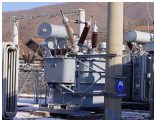
磁控式自动调谐消弧线圈 在丹东太平哨变电站运行
