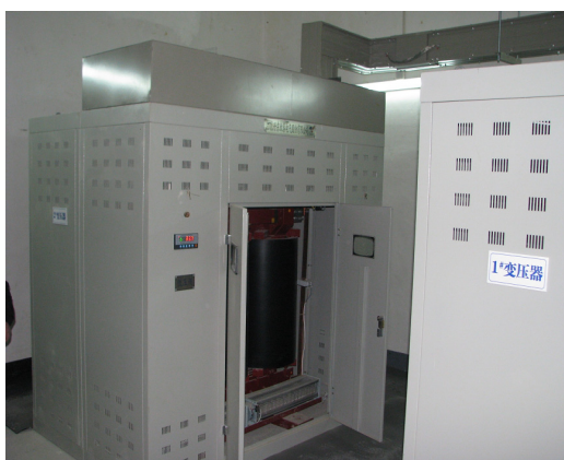
35kV 及以下环氧树脂浇注干式变压器 应用于宝马华晨绿野工厂、武汉电力公司
