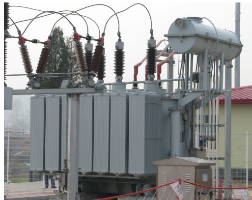
66kV 及以下油浸式电力变压器 广泛应用于东北三省电网
