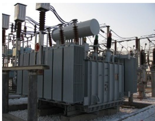
110kV 及以下新型磁控并联电抗器 应用于国网沈阳电力公司张官 220kV 变电站、武钢集团等
